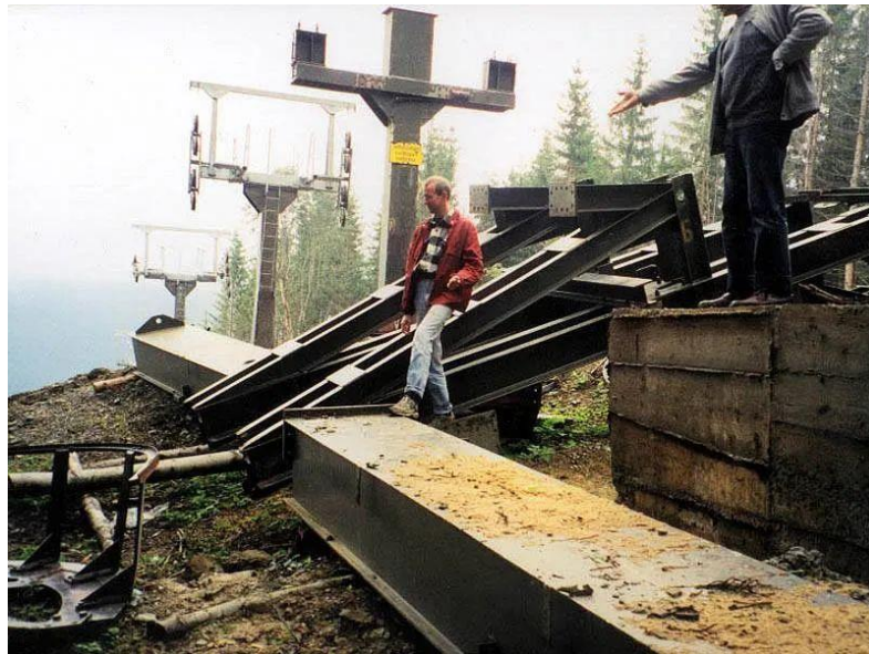
Рис. 7. Початкові етапи будівництва гірськолижного курорту "Буковель". 2000-ні роки. Фото: Кам'яний двір
