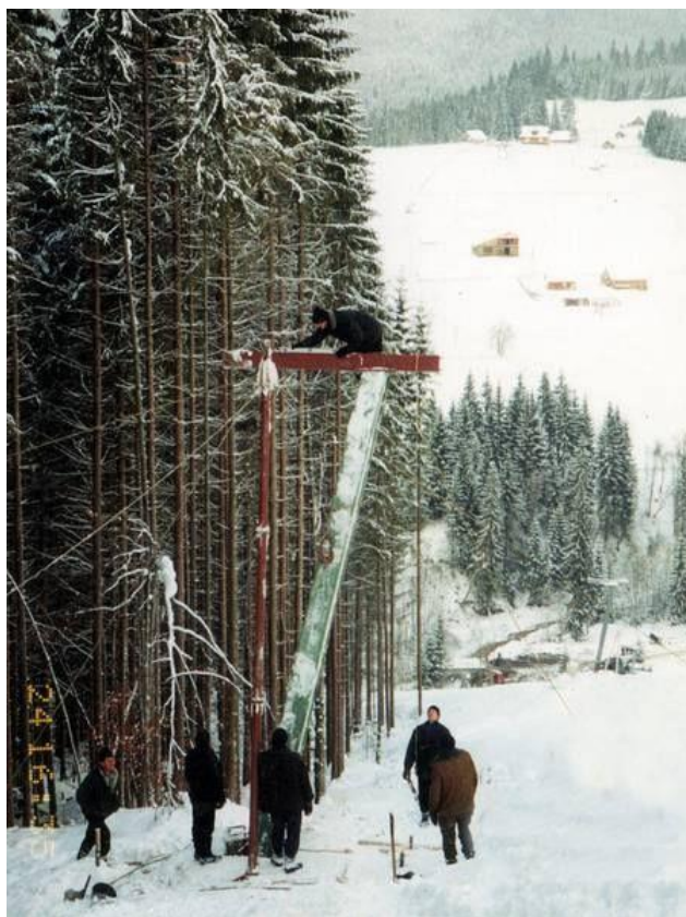
Рис. 40. Будівництво чергового підйомника у "Буковелі". Фото: Кам'яний Двір
