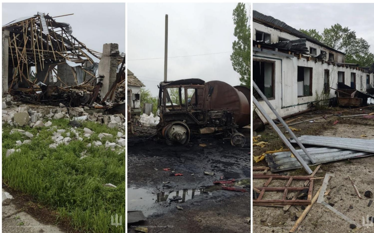
Рис. 1.2. Зруйновані виробничі будівлі та техніка фермерського господарства на Одещині внаслідок влучання ворожих дронів-камікадзе 22.04.2024
