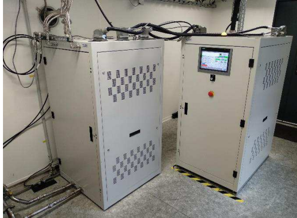
Рис. 3.3 – Зовнішній вигляд модуля постійного струму (праворуч) та ВЧ модуля (ліворуч)
