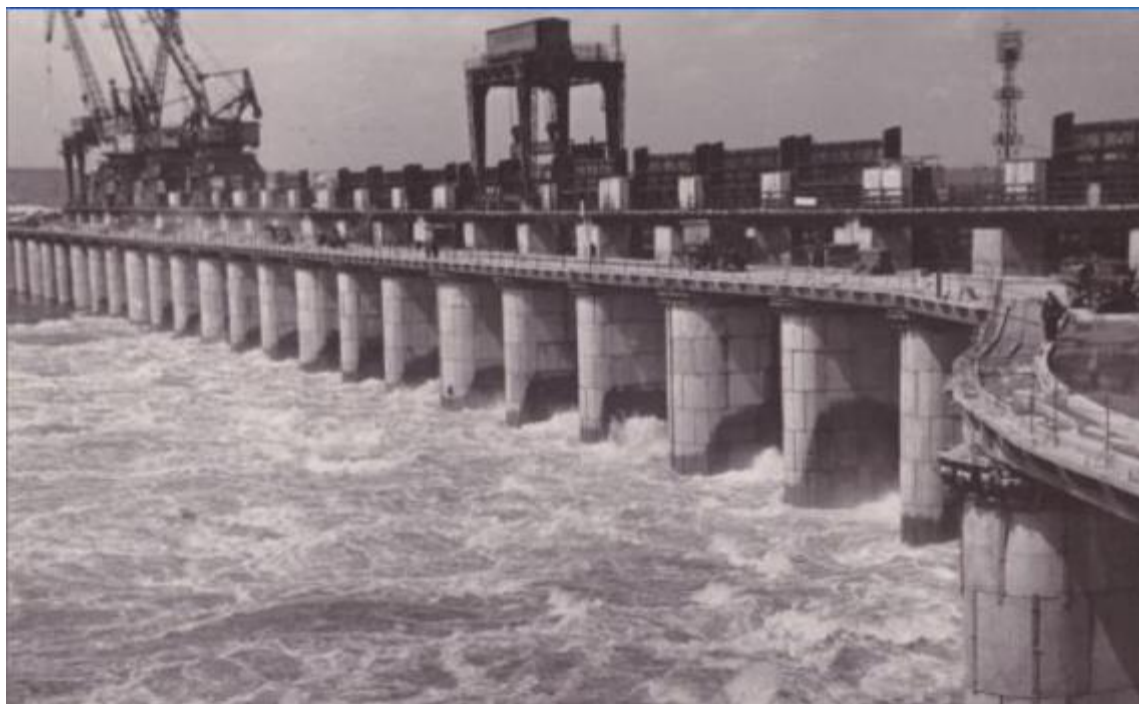
Рис . 1.7 Загальний вигляд бетонної водозливної греблі Каховського гідровузла
