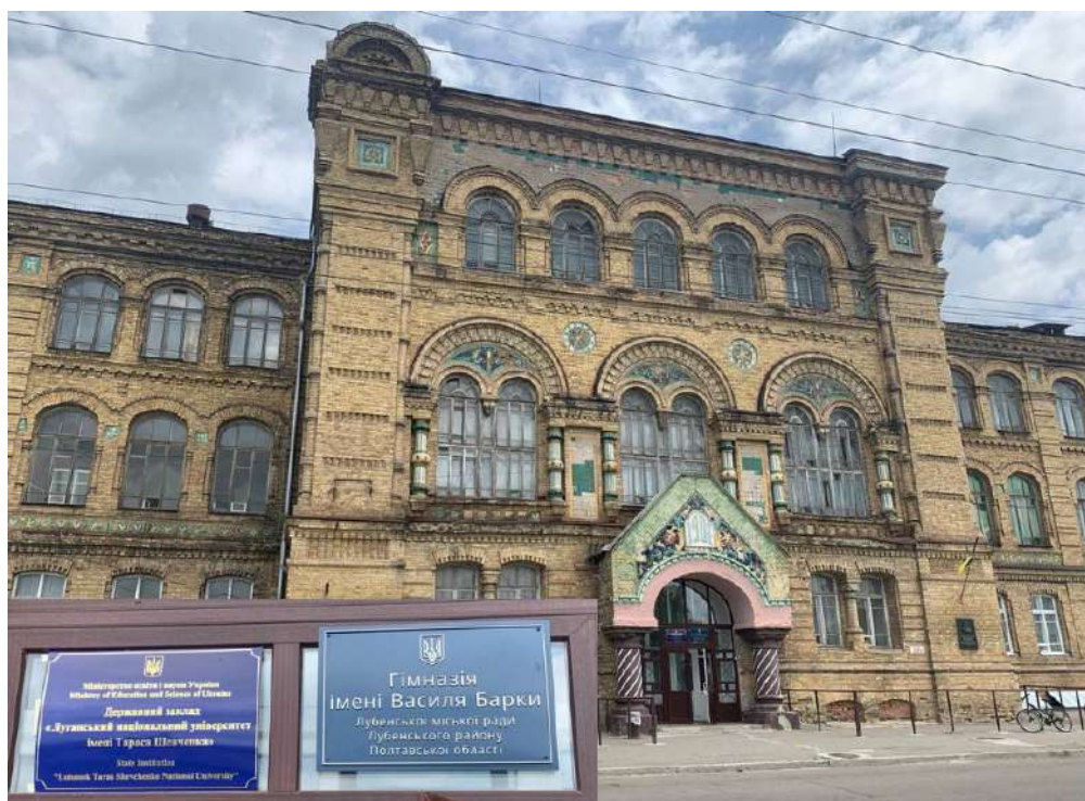
Рис. Л. 2. Фото будівлі гімназії імені Василя Барки Лубенської міської ради Лубенського району Полтавської області, в яку було переміщено Луганський національний університет імені Тараса Шевченка (фото П. Карташова)
