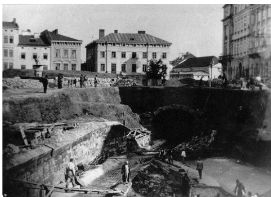
Рис. 1. Відведення русла Полтви під час будівництва Львівського оперного театру
