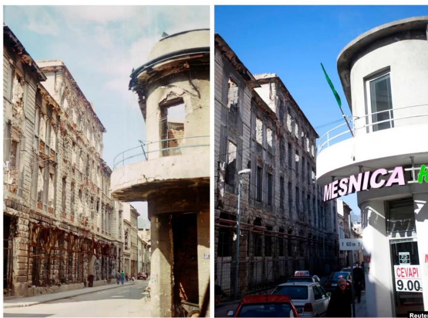
Рис. 1.2. Зруйнована та в подальшому відновлена вулиця Маршала Тіто в Мостарі. Боснія і Герцеговина. Перше фото було зроблено 1993 року, друге – 2013 [39]
