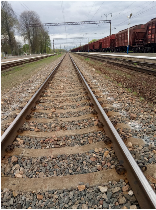
Рис. 4. Ділянка залізниці на станції Крути (фото Лоханька І.С.).
