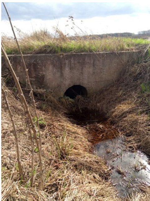
Рис. 9. Грубний мостовий перехід (західна околиця м. Ніжин) (фото Філоненко Ю.М.).
