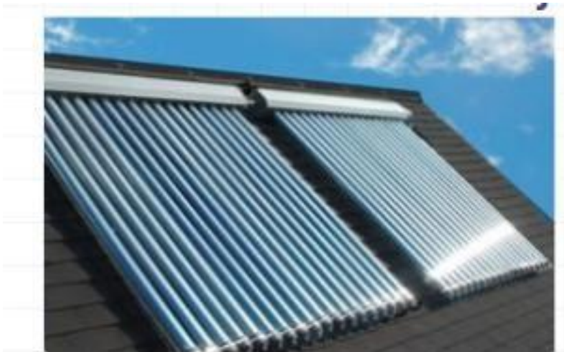
Рис. 1.34. Колектор вакуумних трубок[43]
