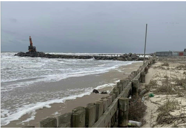
Рис. 5. Вертикальний дерев'яний мур на пляжі під час навіть невеликого хвилювання на морі сприяє відбійному ефекту накату, що спричиняє розмив пляжу з обох боків від буни. Можна бачити залишки дрібних берегових дюн, які розмиваються. (Фото авторів).
