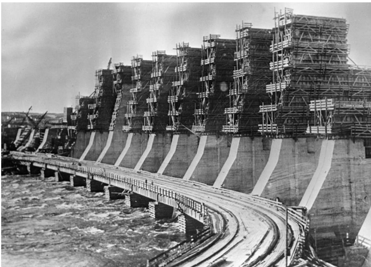
Будівництво Дніпрогесу (місто Запоріжжя)
