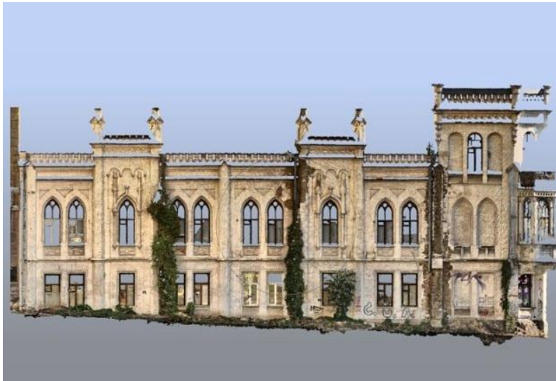
Рис 3.5. 3D модель історичного будинку на бульварі Шевченка в м. Києві, виконана за допомогою лазерного сканування хмарою точок
