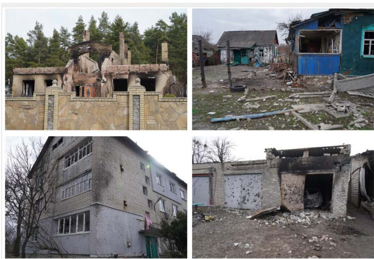
Рис. 14. На фото — зруйноване житло у м. Тростянець
