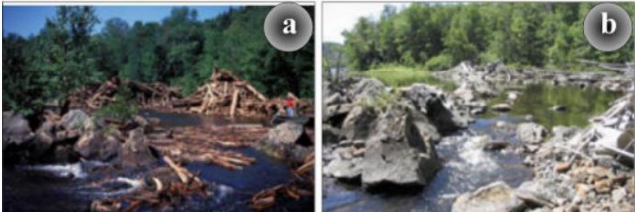
Рис. 3.1. Вигляд ділянки водойми: а) до очищення б) після очищення від колод [20]
