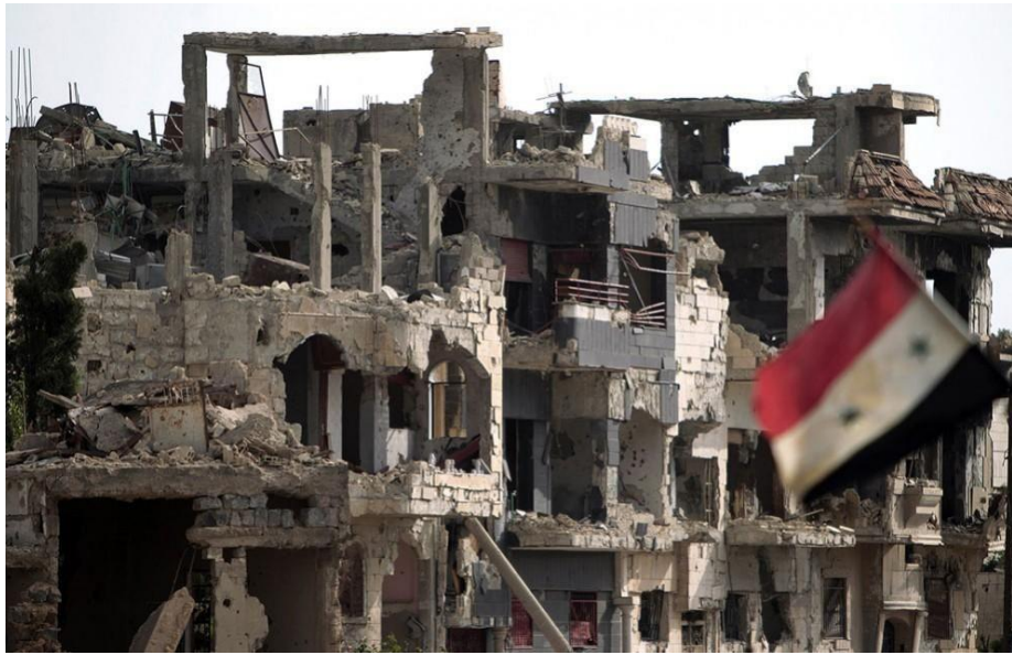
Рис. 2.2 - Знищені будівлі міста Алеппо, 2015 рік
