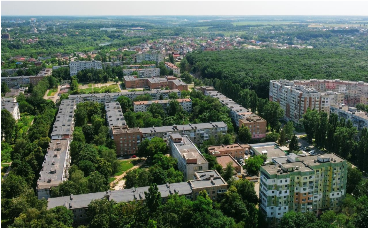
Рис. 2.2. Багатоповерхові житлові будинки м. Полтава
