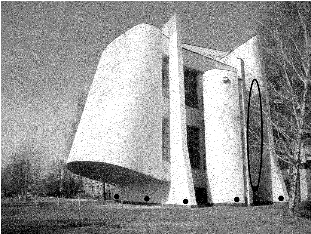
Рис. – Будівля Фізичного факультету КНУ імені Тараса Шевченка. Виділені місця закладення контрольних стінних марок та зона виникнення тріщини розкриття
