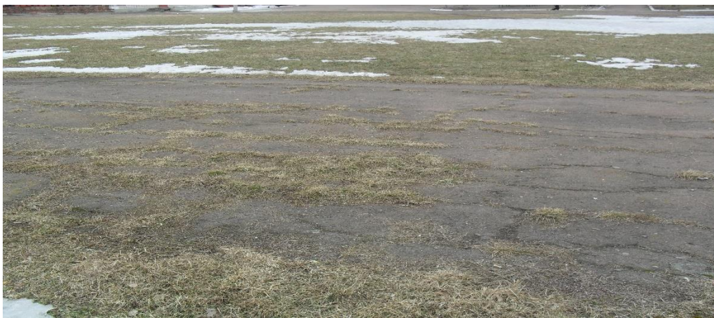
Рис. 5 – Дерново-трав'янисті горбки та мікропасма на поверхні асфальтного покриття
