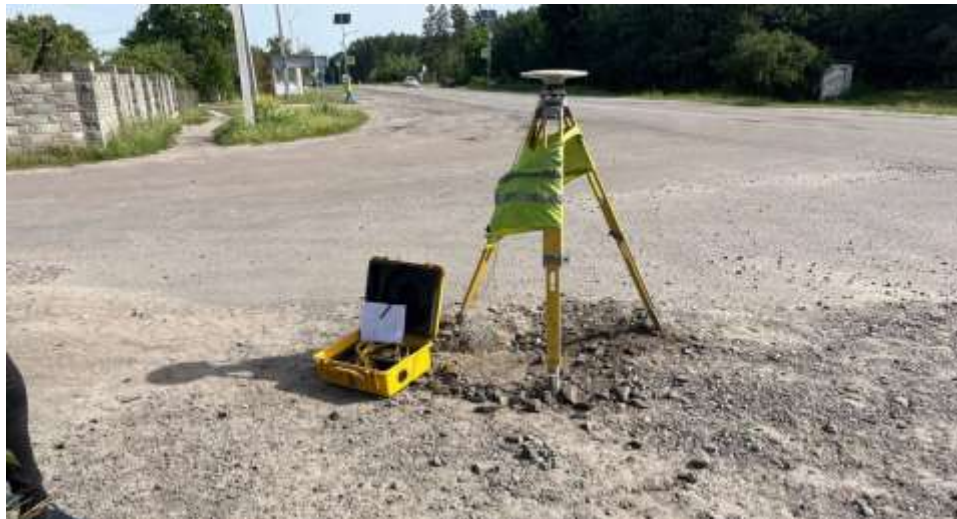
Рис. 2.5 Фіксація координат точки перед встановленням межових знаків
