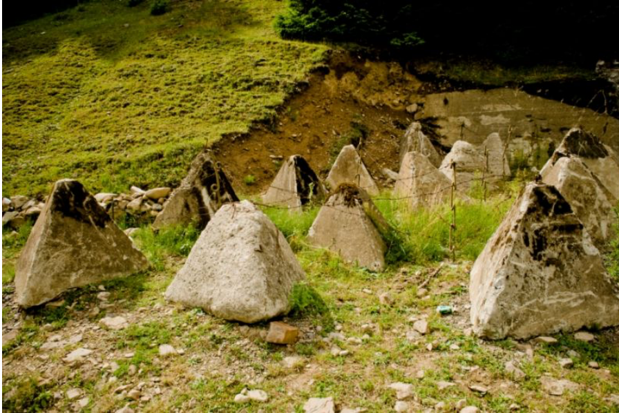
Рис. 2.3. Кам'яні піраміди - перешкоди для танків Лінії Арпада
