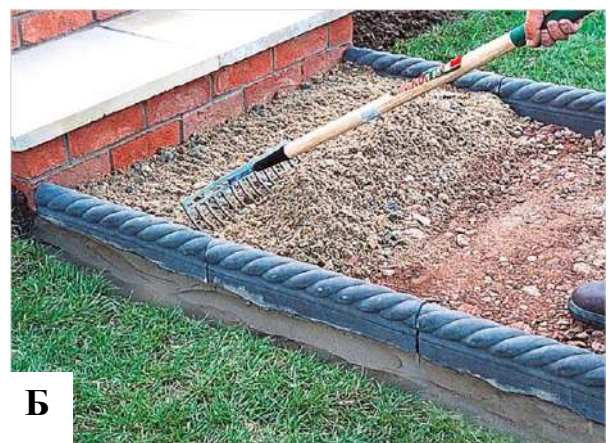
Рис. 4.4. Створенням доріжки. Розмітка доріжки (А). Укладання "подушки" (Б)
