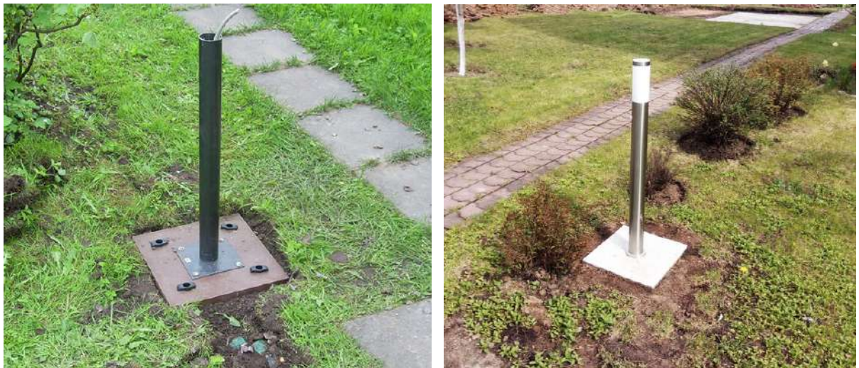
Рис. 4.2. Загальний вигляд бетонування підстав для ландшафтних світильників
