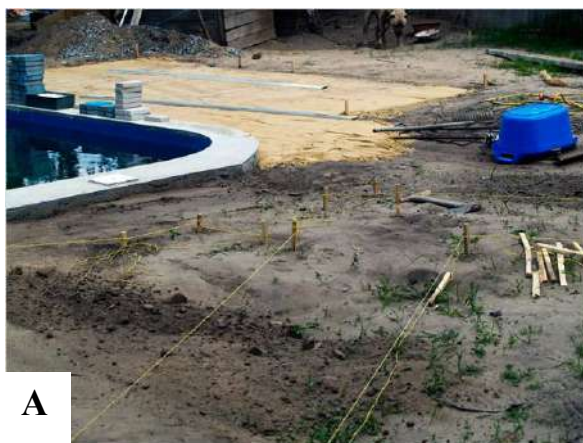
Рис. 4.4. Створенням доріжки. Розмітка доріжки (А). Укладання "подушки" (Б)
