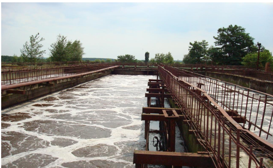
Рис. 1.10 Очисні споруди Коростенського КП «Водоканал»
