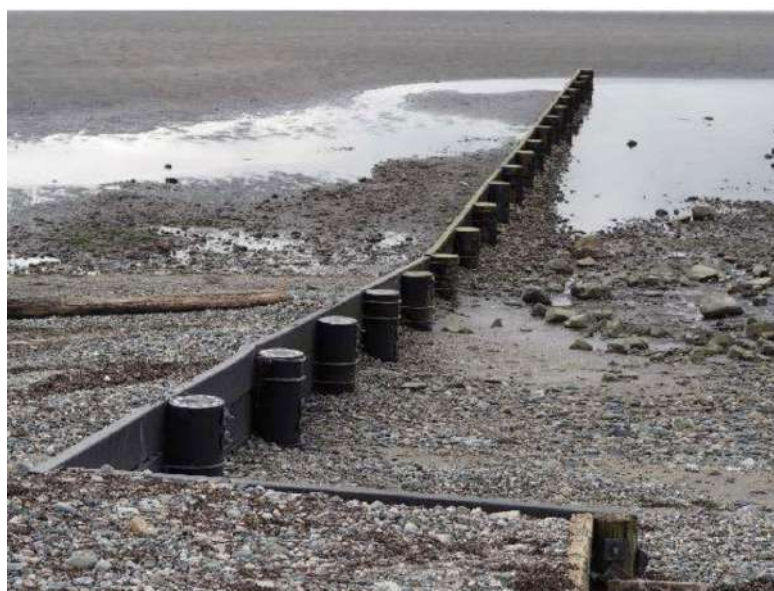
Рис. Б.2. Приклад укріплення берегу на пляжі Кресент, Сюррей, Канада [96]
