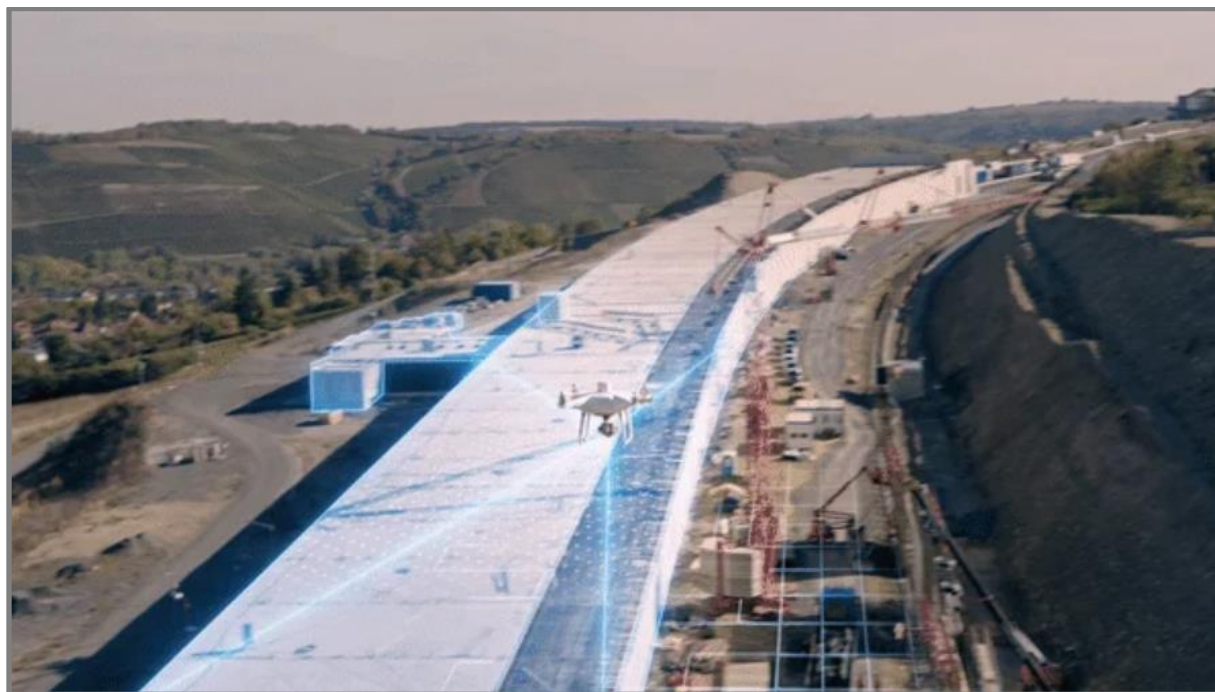
Рис. 2. Сканування БПЛА поверхні майбутньої дороги (з сайту enterprise.dji.com )
