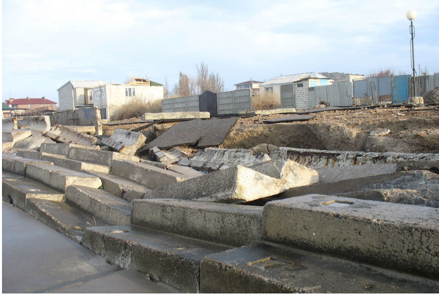
Рис. 3. Морська окрайка території міста Бердянськ (узбережжя Азовського моря, Україна). Через 7 років споруда вийшла з ладу, тому що не були враховані підводні ухили, дія криги та хвильові тиски. Фото: А. В. Давидова.
