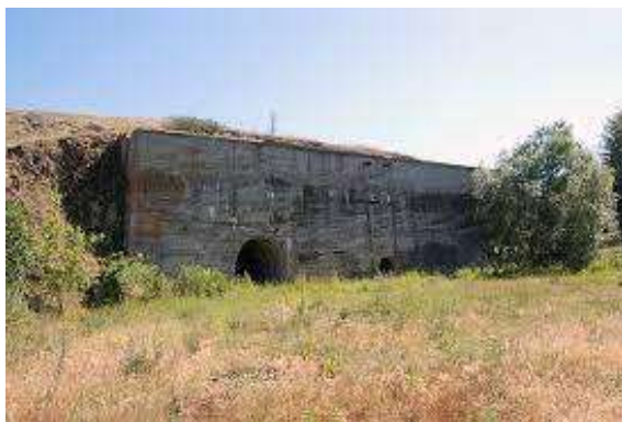
Рис. 1.6 Закинута штольня в с. Чермалик[55]
