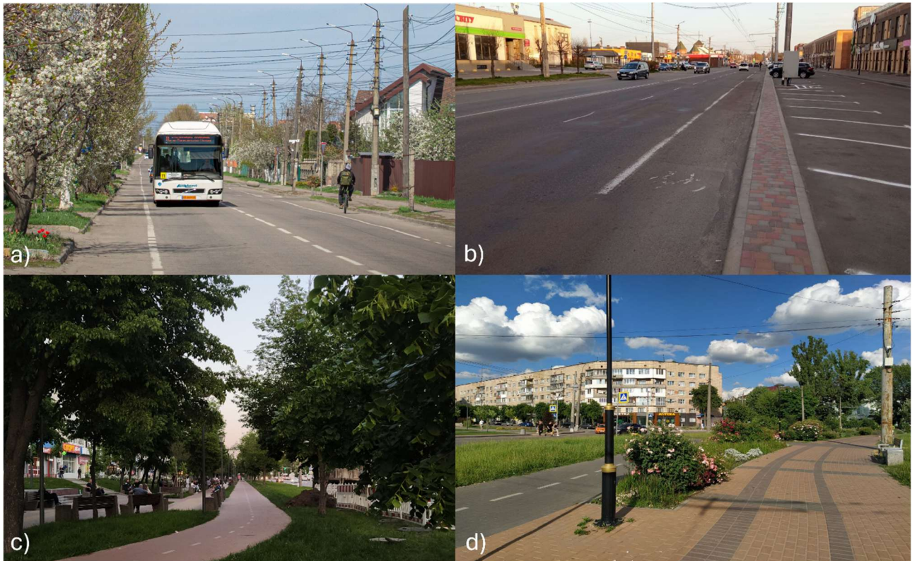
Рис. 3.5. Приклади організації велоінфраструктури в м. Біла Церква: а, б – крайові смуги із рідко нанесеними піктограмами, що не відповідають ДБН В.2.3-5:2018 та ДСТУ 8906:2019; с – велодоріжка на просп. Незалежності; д – велодоріжка на бульв. Олександрійському
