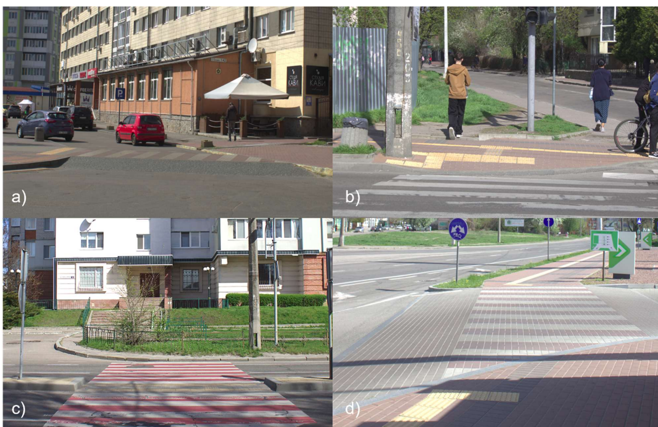
Рис. 3.4. Недоліки пішохідної інфраструктури виявлені в ході обстеження маршруту «Залізничний вокзал – ж/м Таращанський): а – фрагментарність укладання тактильної плитки; b, d – вкладання попереджувальної тактильної смуги з порушенням ДБН В.2.3-5:2018; с – пішохідний перехід, що веде у огороження
