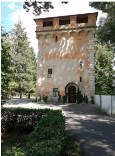
Рис. 7. Водонапірна вежа XIX ст. – сучасна споруда музейної колекції
