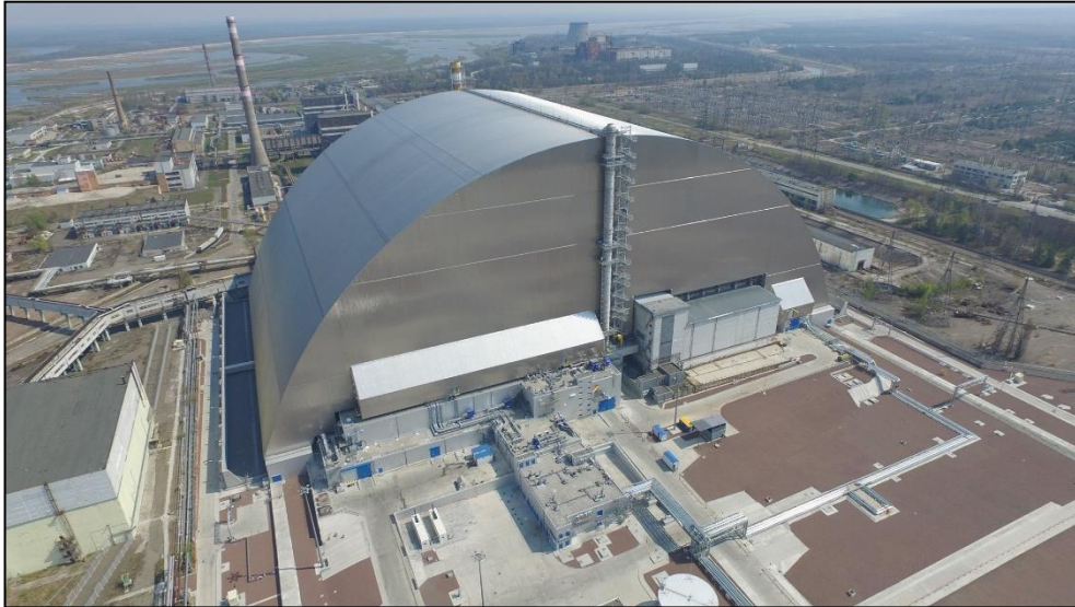
Рис. 2.1. Загальний вигляд комплексу нового безпечного конфайменту Чорнобильської АЕС
