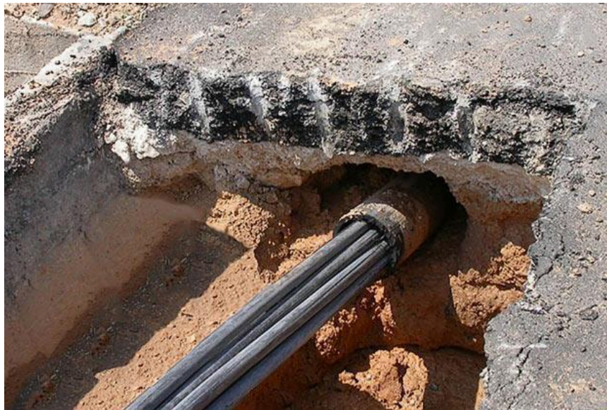
Рисунок 2.1 Метод шурфування
