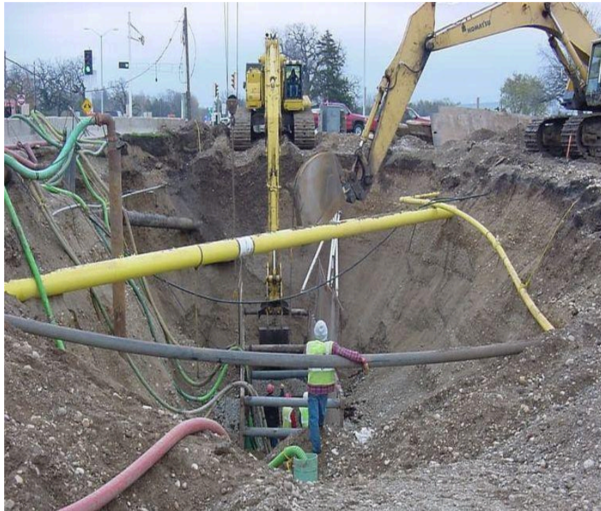
Рисунок 1.1 – Процес прокладання підземних комунікацій Теплові мережі
