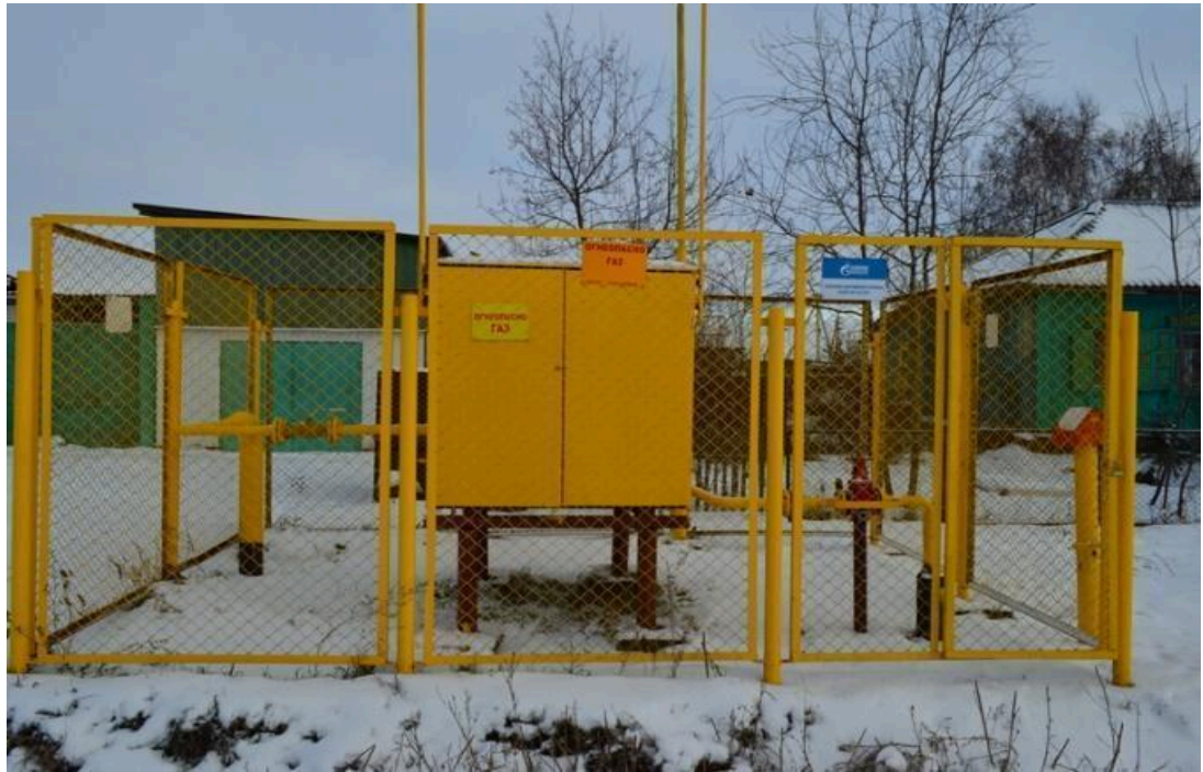
Рисунок 1.5 – Газорозподільна станція
