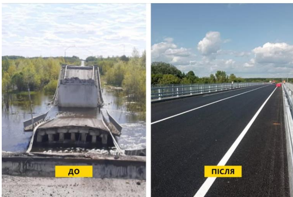
Рис. 4.5. Міст через р. Сейм в м. Батурин на весні 2022 року та після відновлення в 2024 році [22]
