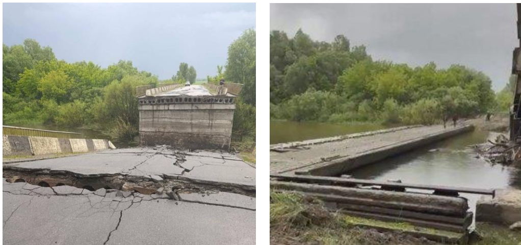
Рис. 4.3. Міст через р. Сейм в с. Озаричі 13.06.2025 року та після відновлення в 2025 році [28]
