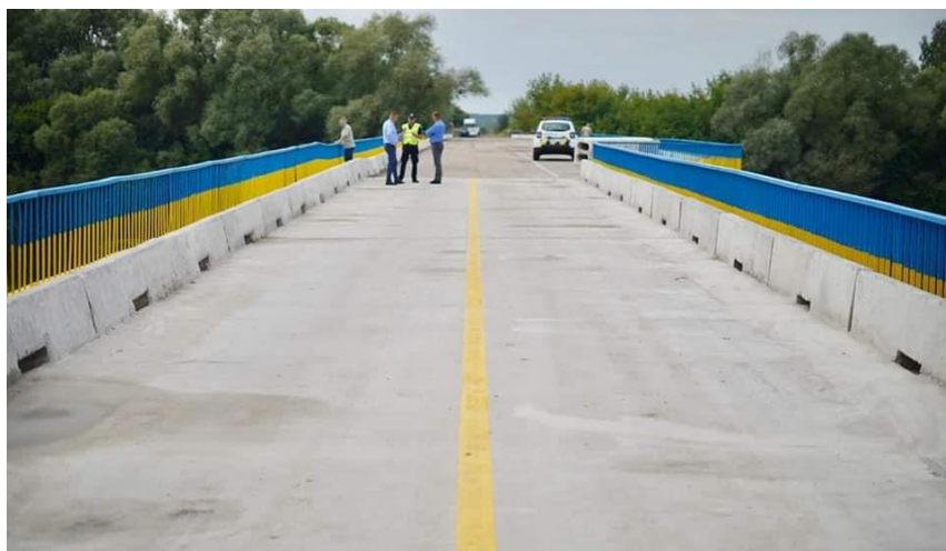
Рис. 4.2. Відновлений залізо-бетонний міст через р. Сейм (с. Новомутин – Мутин) [28]
