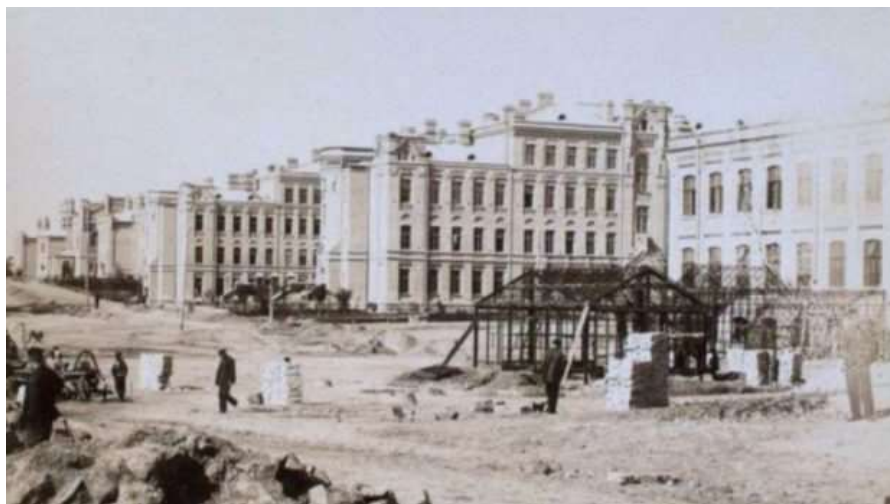
Рис.2.4. Будівництво політехнічного інституту, 1890 рік.
