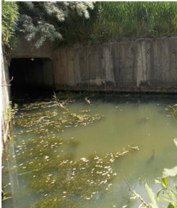
Залізобетонна дамба у верхів'ї р.Ковжижі. 2015 р.
